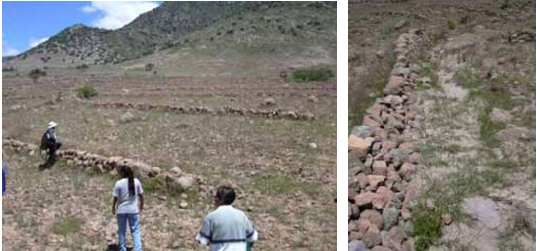
Muros de piedra para frenar el agua, captar sedimentos y materia orgánica y formar terrazas.
